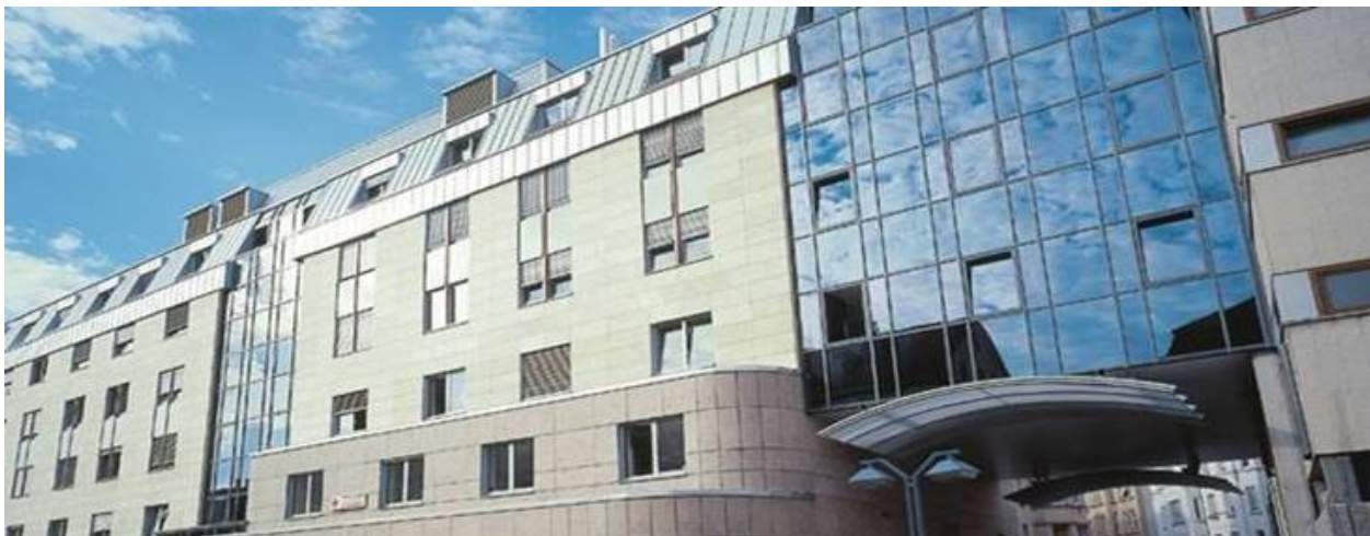
Krankenhaus vom Roten Kreuz Bad Cannstatt GmbH, Vorderansicht Badstraße
